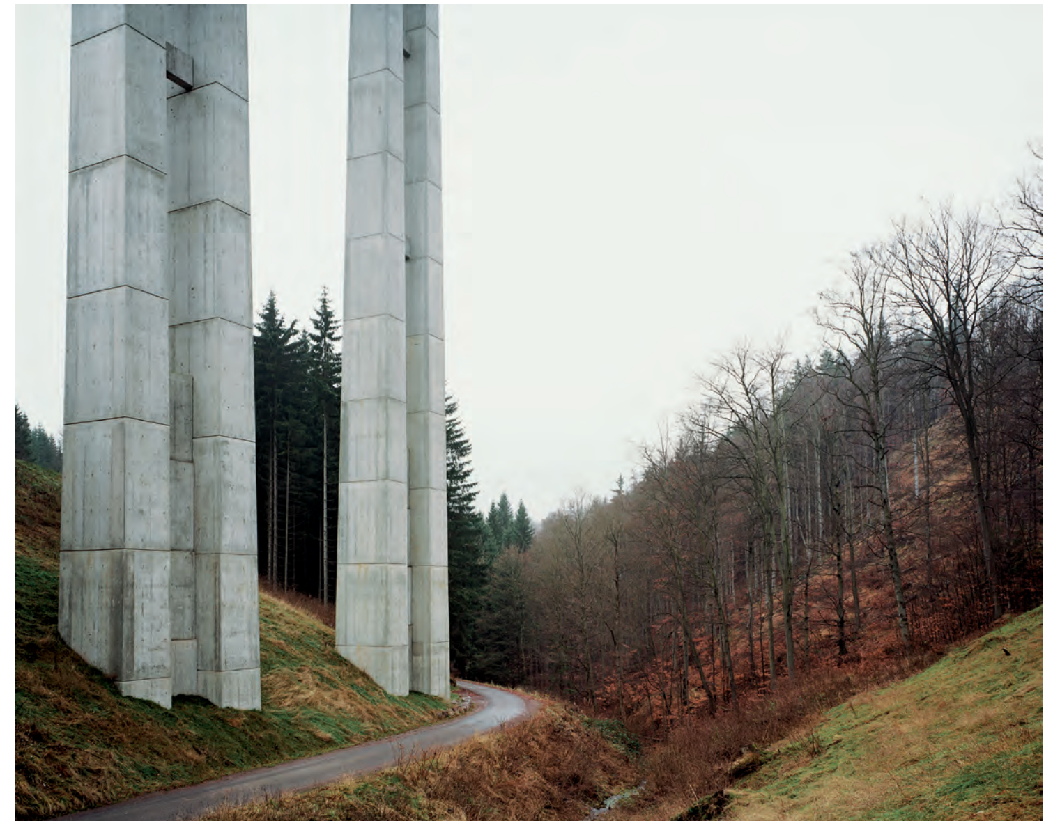
A 71, Brücke Schwarzbachtal
